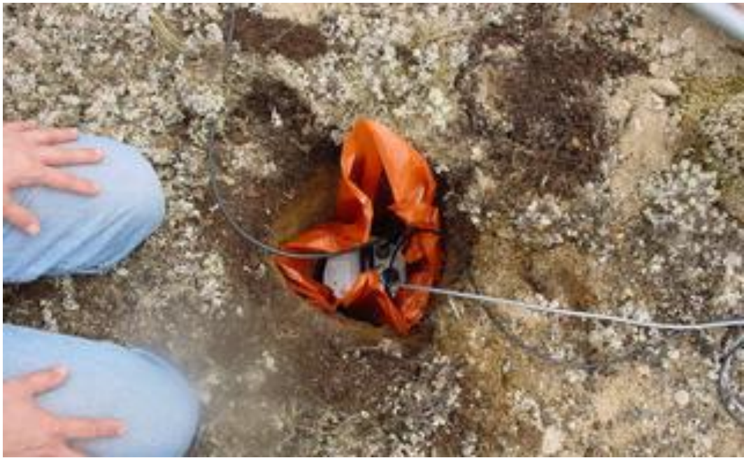
Рис. 3-9 Установка в яму
