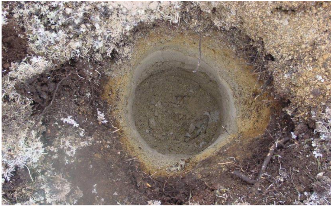
Рис. 3-8 Яма для быстрой установки прибора
